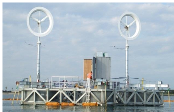
図1 洋上風力発電装置 全景
